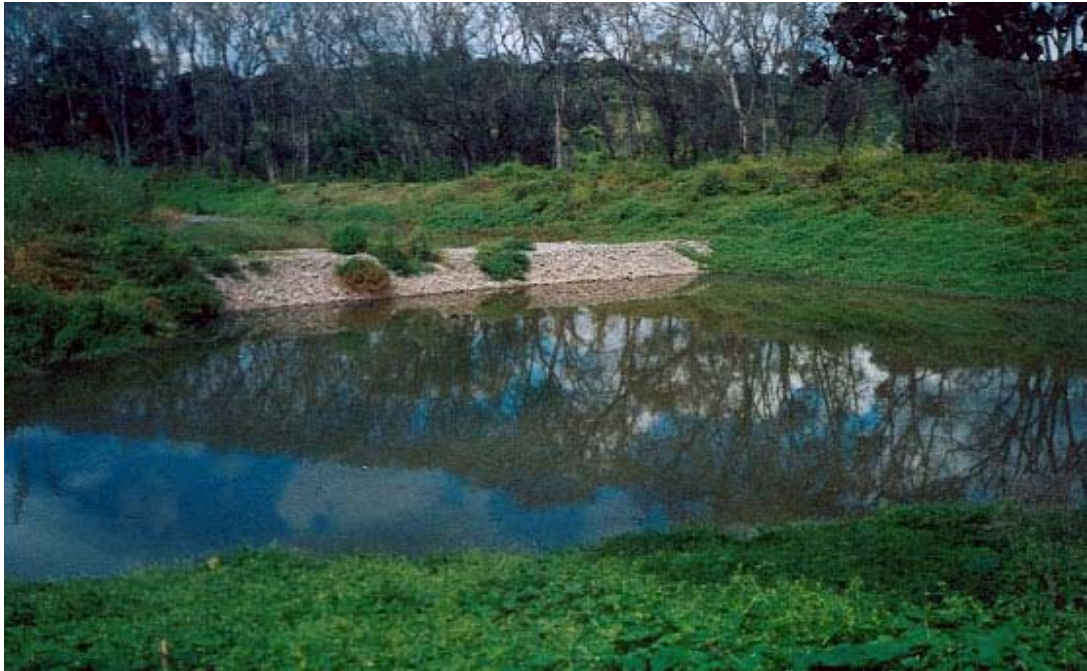
Figura 6-1 Laguna de tratamiento de aguas residuales de Mexiticacán
