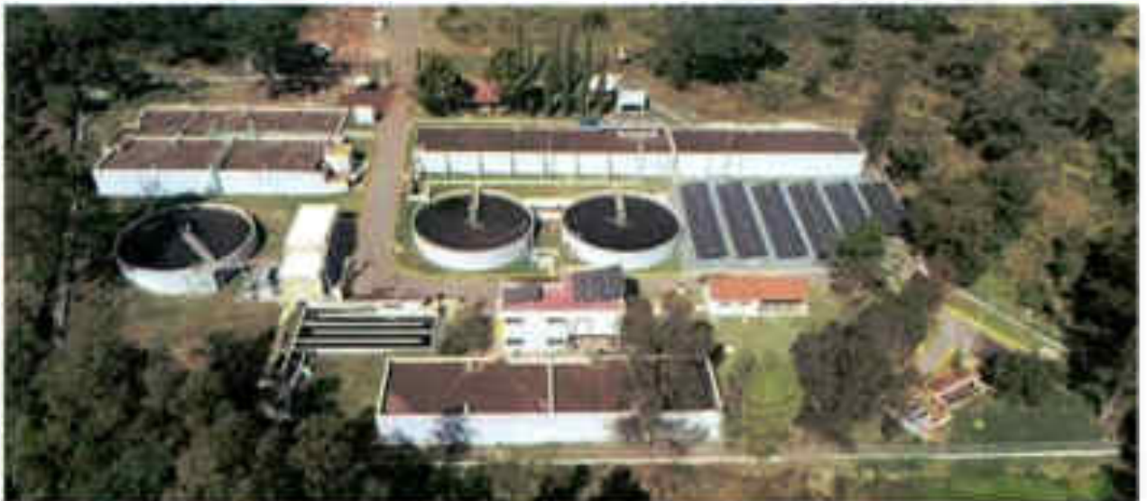
Vista aérea de la PTAR Arandas
