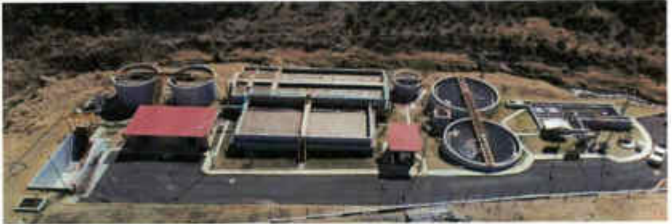
Vista aérea de la PTAR Yahualica
