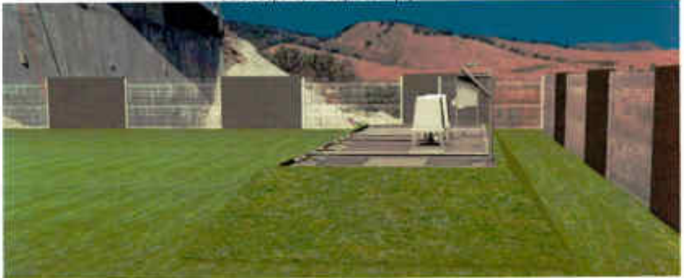
PTAR Copalita, municipio de Zapopan
