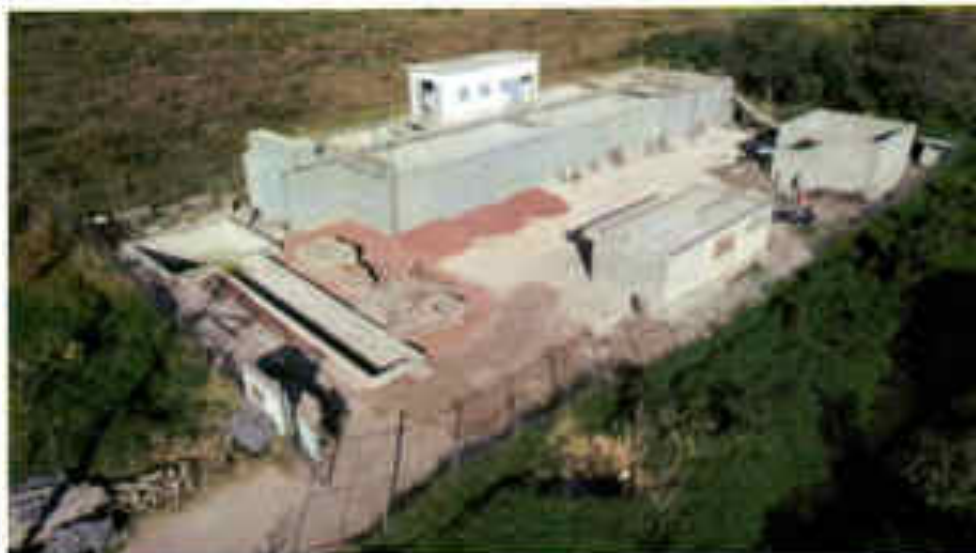
Vista aérea PTAR Varías Localidades Ixtlahuacán de los Membrillos
