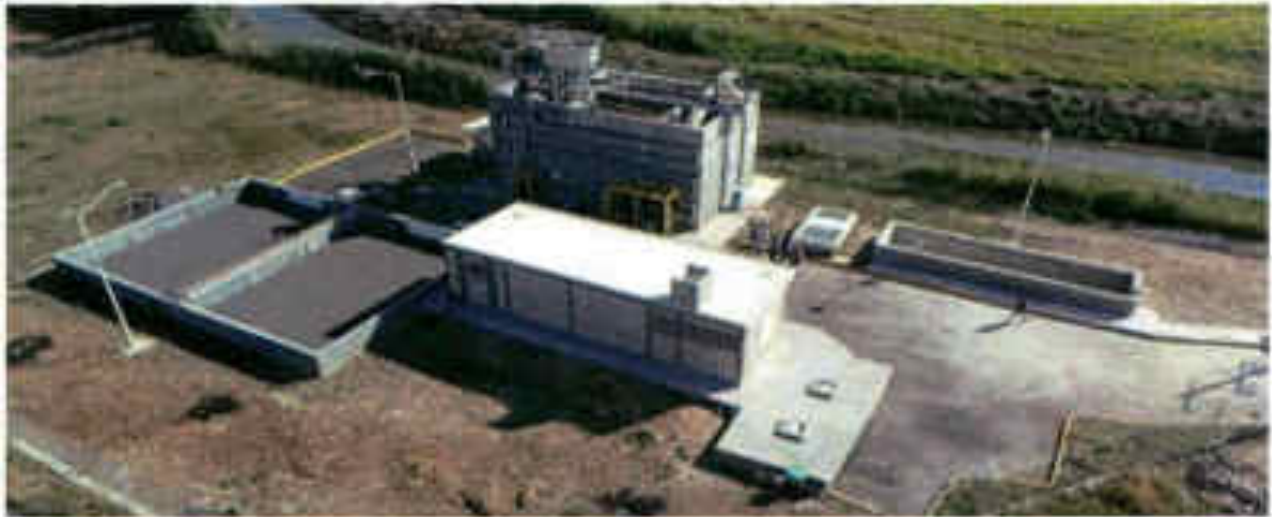
Sembrado general de unidades de tratamiento, La Capilla, municipio de Ixtlahuacán de los Membrillos
