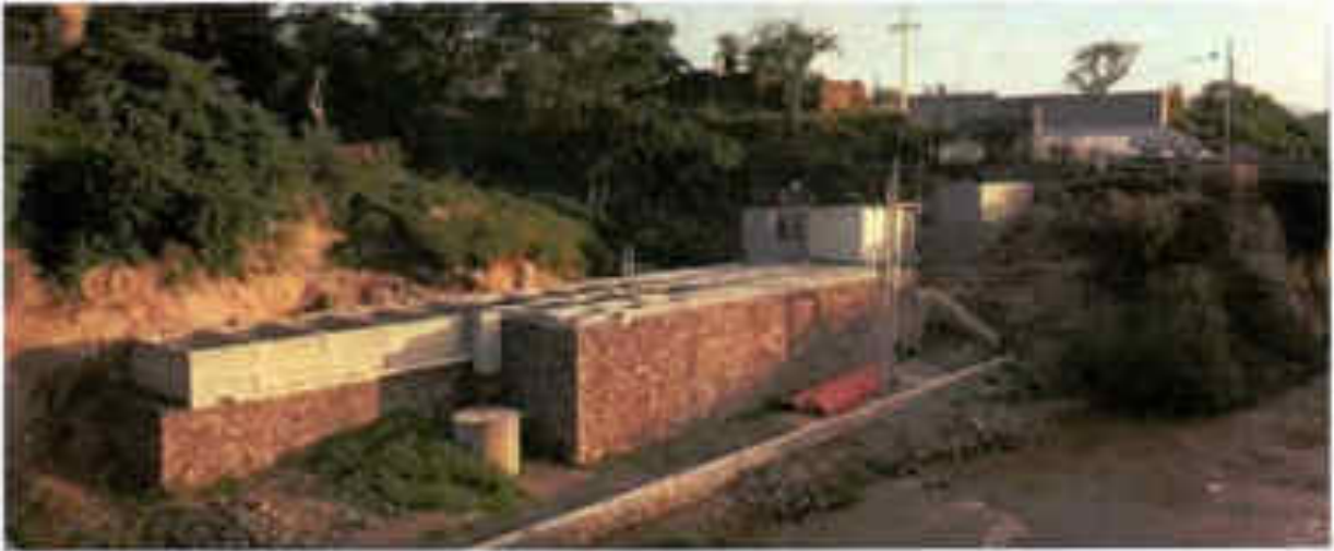
Vista de la PTAR San Martín de Bolaños
