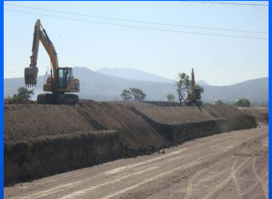
CONFORMACIÓN DE TALUD
