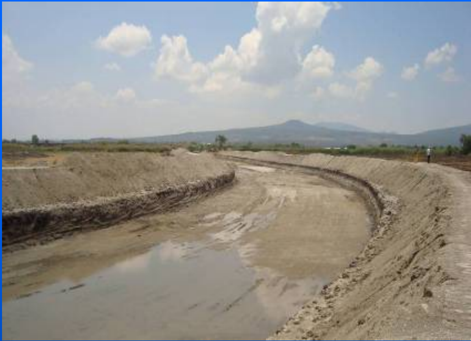
CONFORMACIÓN DE BORDOS SEGUNDO TRAMO
