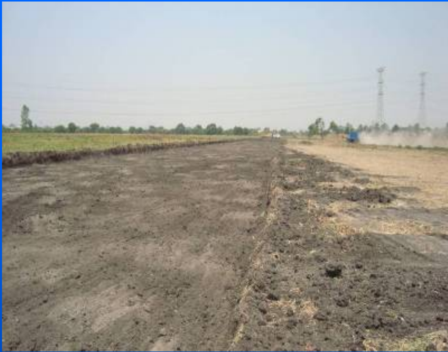
DESPALME DEL TERRENO
