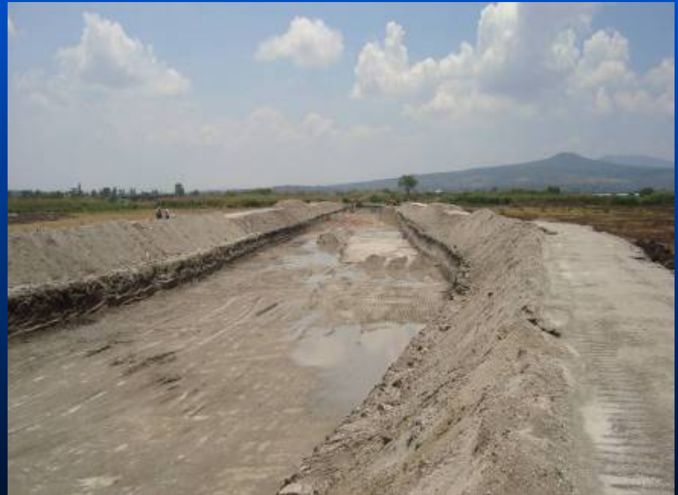
TRAMO FINAL PREVIO A LA CONEXIÓN DE LA DESCARGA
