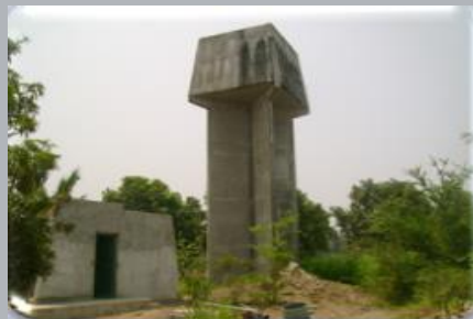
Tanque elevado de concreto
