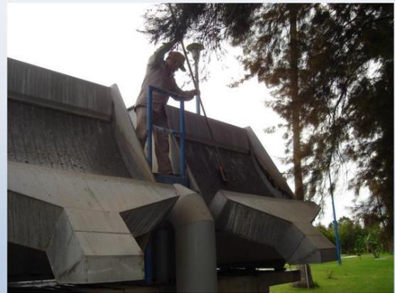
**Tanques de Aireación:** En esta unidad se lleva a cabo la dosificación de oxígeno requerido para lograr el desarrollo de microorganismos encargados de efectuar la degradación de la materia orgánica.
