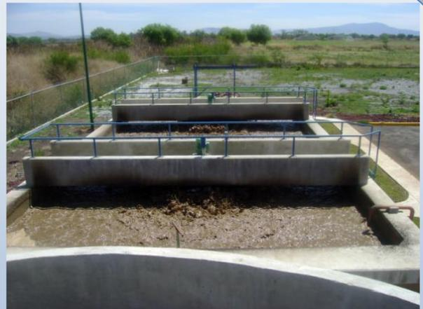
**Tanque espesador de lodos:** Permite aumentar la concentración de sólidos y formar un lodo más espeso.
