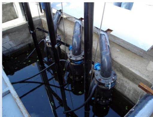
**La caja distribuidora** recibe el agua residual para ser distribuida de manera uniforme hacia las hidrocribas instaladas, previa a la entrada de los tanques de aireación.
