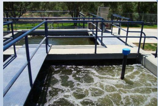
**Tanque sedimentador:** Se lleva a cabo la precipitación por gravedad del lodo digerido resultante del tanque de aireación, el lodo se va al fondo y el agua clara se recolecta en un canal en la parte superior.
