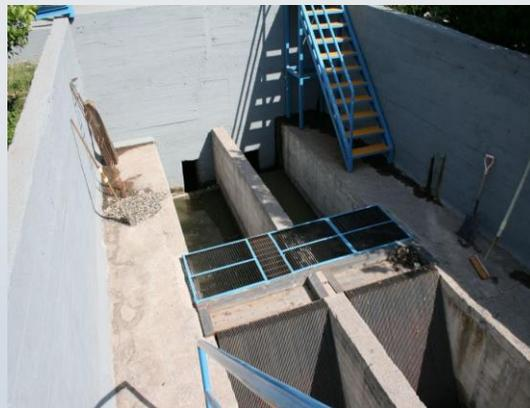
**Canal desarenador** que permite eliminar material sedimentable como arenas gravas y basura.
