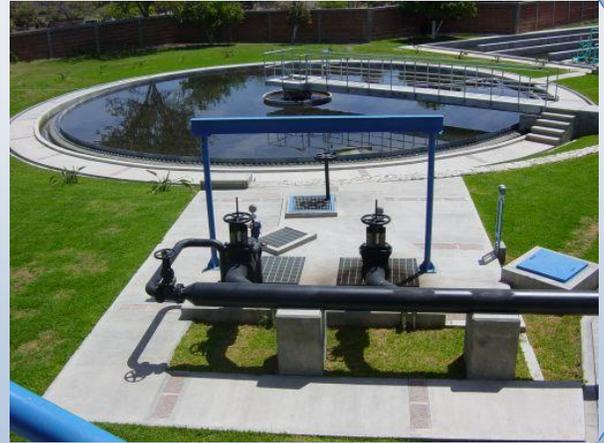
**Sistema de cloración:** En este proceso se lleva a cabo la eliminación de los organismos patógenos mediante la adición de compuestos de cloro como hipoclorito de Sodio y tabletas de cloro.
