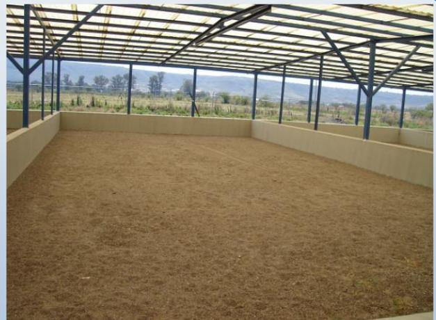
**Biofiltro:** Proceso de tratamiento biológico secundario en donde se utiliza un material inerte para que se adhieran las bacterias y se forme una película fija, el agua a tratar se esparce en la parte superior y escurre por este medio fijo y las bacterias toman su alimento con oxígeno.
