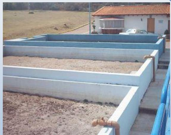
**Digestor de lodos:** Tiene la función de concentrar el exceso de lodo y neutralizarlo por medio de aireación se oxida la materia orgánica, se reduce el lodo para dejarlo como abono natural inerte para posteriormente enviarlo a los lechos de secado o filtro banda (desaguado de lodos).
