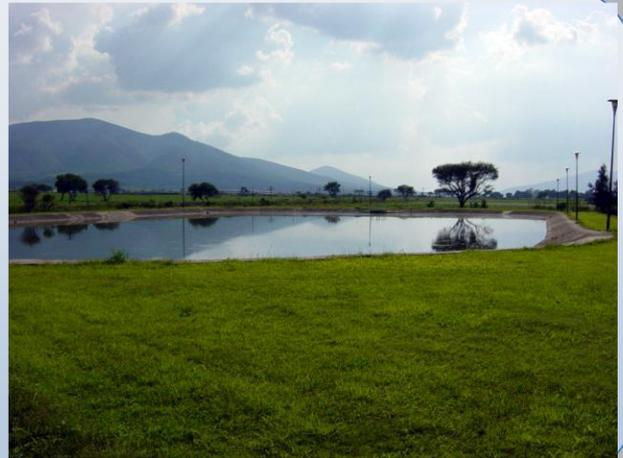
**Laguna aireada:** Proceso biológico secundario, combina proceso anaerobio y aerobio mediante elementos mecánicos. y/o motores para mezclar el aire con el agua a tratar.
