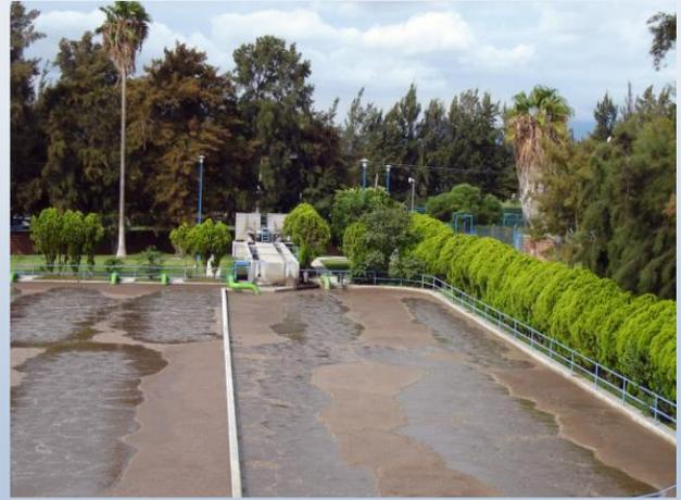
**Lechos de Secado:** Es un sistema de filtración a través de un medio de arenas y grava los cuales retienen los sólidos en la parte superior para su desecación, mientras que la porción líquida es regresada al proceso de tratamiento
